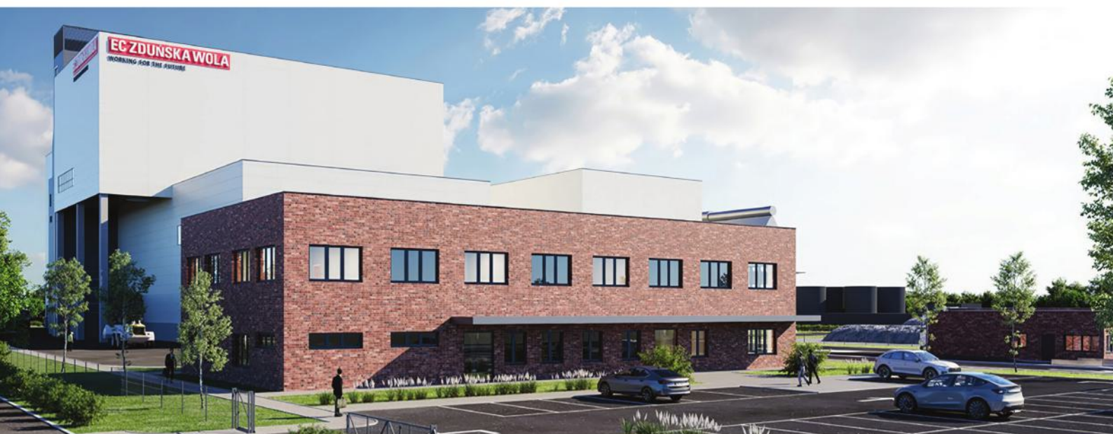
Tak ma wyglądać spalarnia w Zduńskiej Woli
